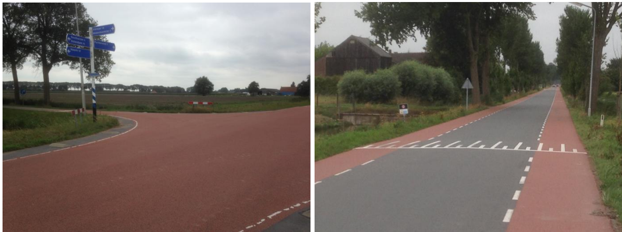
Afbeelding 7 en 8: Rood asfalt met gemodificeerd kleurloos bindmiddel. Afgezien van randschade verder geen schade in 2019.
