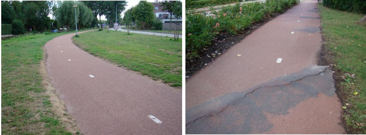
Afbeelding 9 en 10: Fietspad met gemodificeerd kleurloos bindmiddel aangelegd in 2005. Afgezien van wortel en randschade verder geen schade in 2023.
