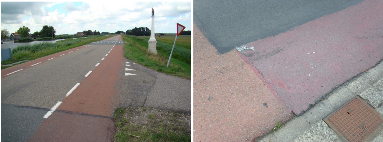
Afbeelding 1: Links bitumineuze oppervlakbehandeling.
